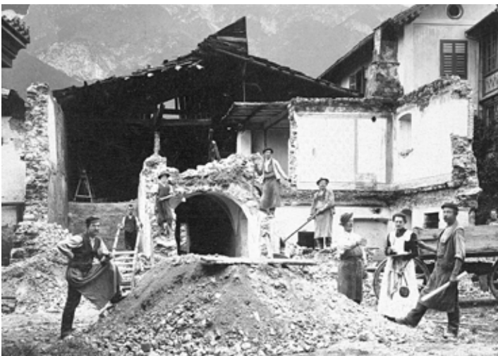
Beim Bau des neuen Kaffee-Restaurants im Jahr 1907.
